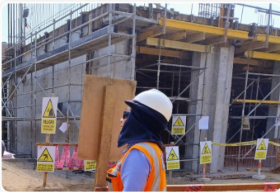
Enconfrado de losa de primer nivel
