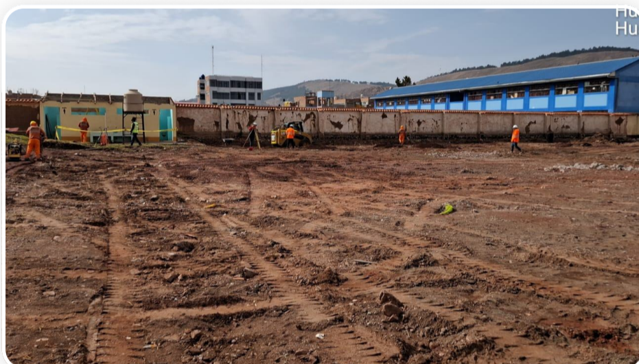
Situación actual del terreno
