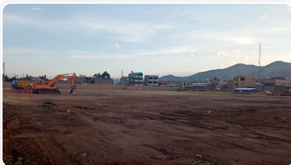
Situación actual del terreno
