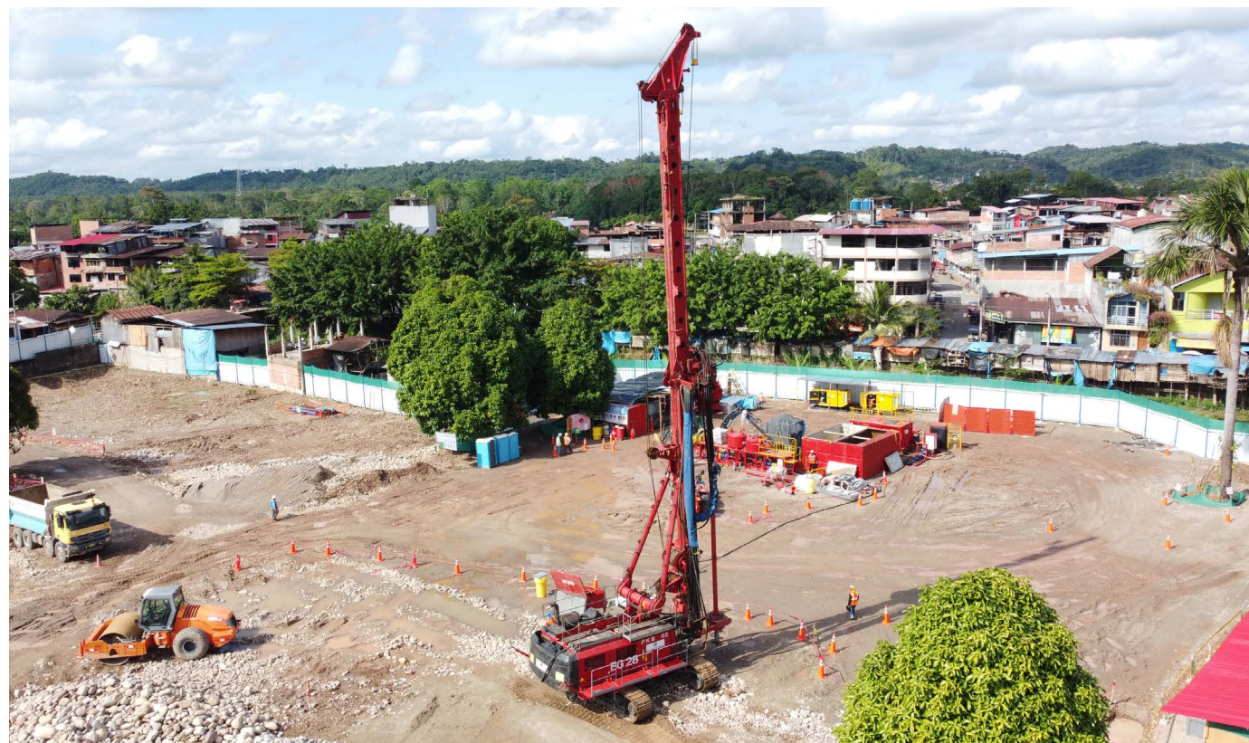
Máquina Pilotera realiza la inclusión de pilotes en el terreno.
