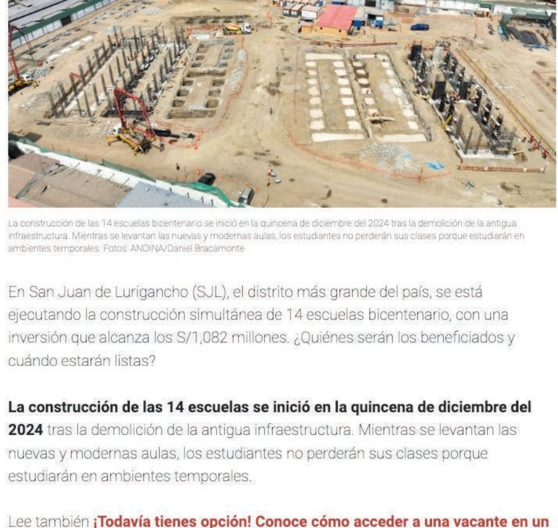
La construcción de las 14 escuelas bicentenario se inició en la quincena de diciembre del 2024 tras la demolición de la antigua infraestructura. Mientras se levantan las nuevas y modernas aulas, los estudiantes no perderán sus clases porque estudiarán en ambientes temporales. Fotos: ANDINA/Daniel Bracamonte
